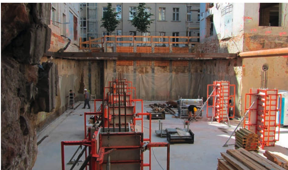
Bild 1: Hergestellte Litzenanker in der Baugrube für die Tiefgarage
