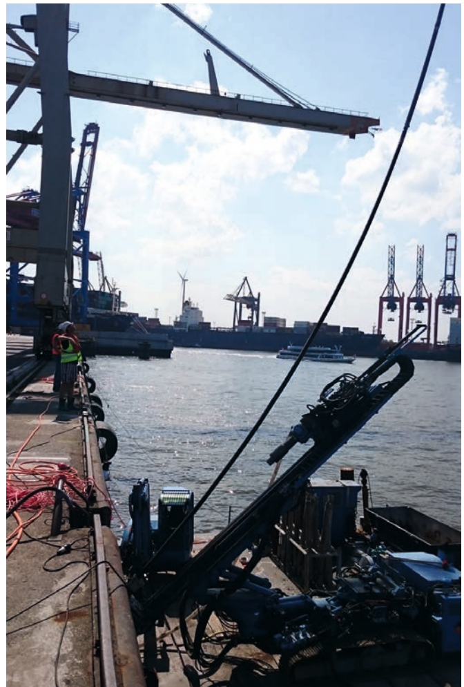
Bild 2: Einbau des Stahltraggliedes
