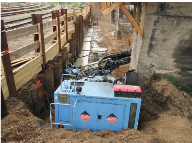
Bild 1: Ankerarbeiten in der 1. Ankerlage
