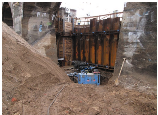
Bild 2: Horizontalankerherstellung
