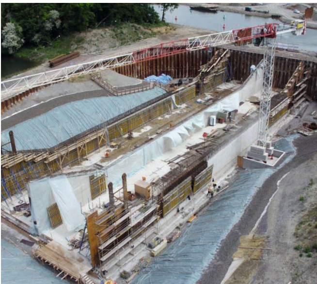
Bild 2: Neues Emscher Bauwerk vor Flutung der Trockendocks
