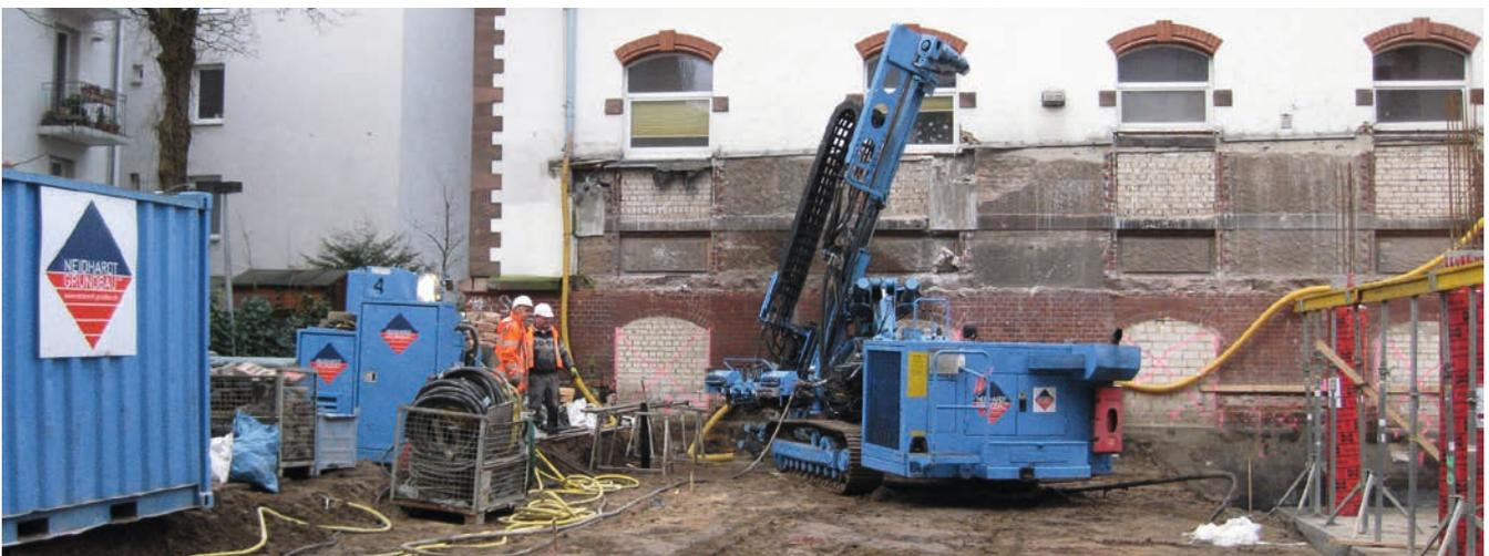
Bild 2: Pfahlherstellung für den Sonnenschutz
