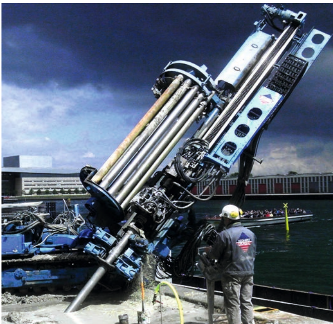
Bild 1: Überkopfbohrung zur Herstellung von geneigten Mikropfählen
