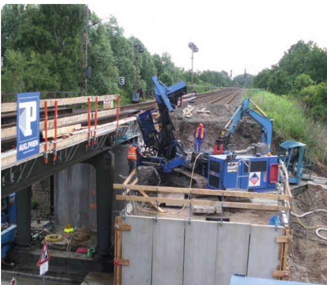
Bild 1: Obere Bohrebene auf dem Widerlager
