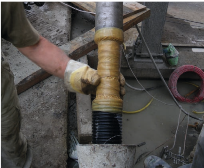
Bild 2: Muffenstoß vor Montage des Schrumpfschlauchs
