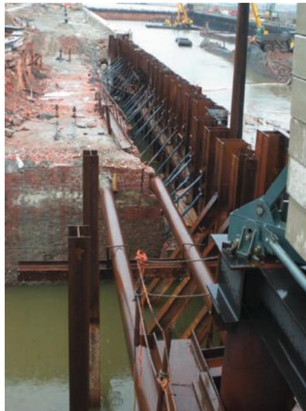
Bild 8a und 8b: Querschnitt durch die Kammerwand West im Bereich des Außenhauptes und Blick auf die fertiggestellten Verpresspfähle der Kammerwand West.
