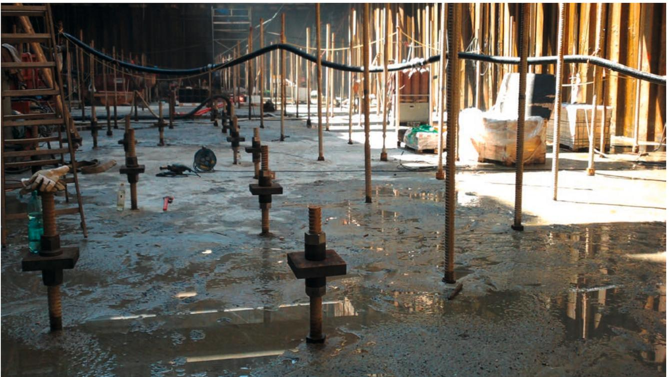
Bild 6: Blick in die gelenzte Torkammer auf die Pfahlköpfe für die Konstruktionssohle
