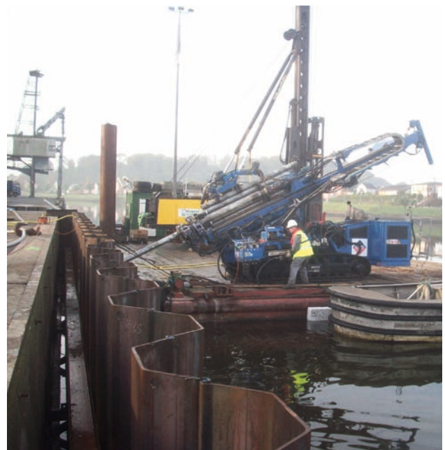
Bild 1: Bohrarbeiten auf dem Ponton
