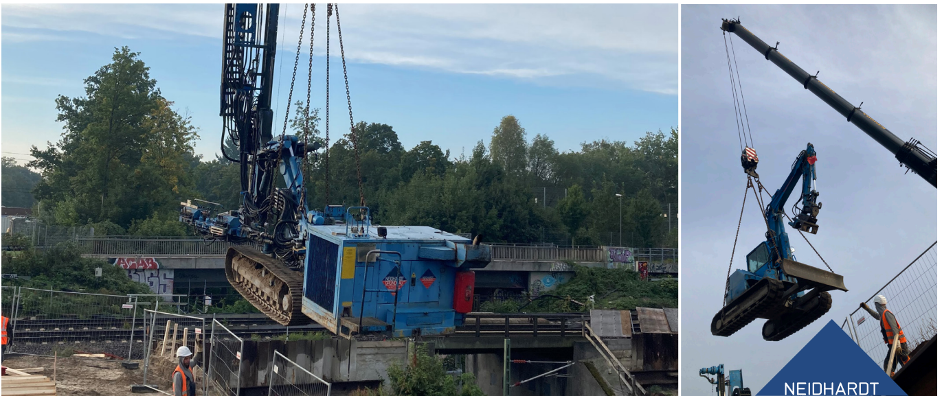
Abb. 1+2. Kraneinsatz zum Einhub des Bohrgeräts . Fotograf: Lorenz Dörwald.
