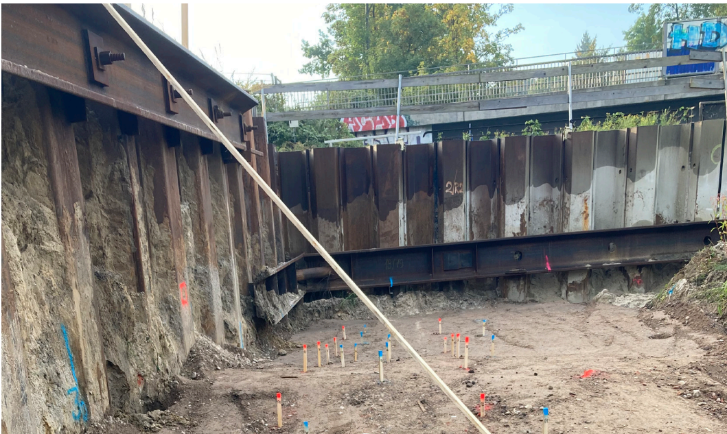
Abb. 3. . Baugrube mit Markierungen. Fotograf: Lorenz Dörwald.
