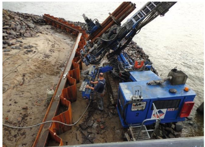
Bild 2: Bohren eines 45° geneigten Pfahles
