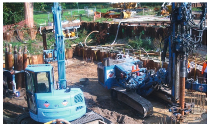
Bild 2: Mikropfahlherstellung zwischen den Ortbetonbohrpfählen
