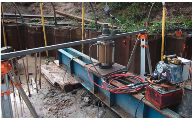
Bild 1: Probelastung an Probepfahl
