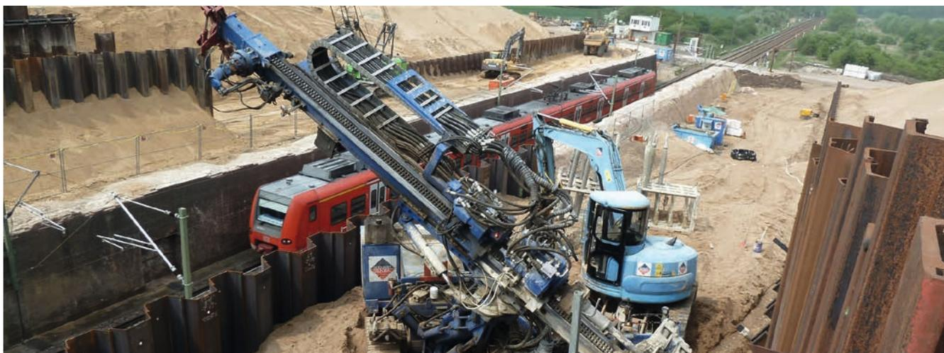
Bild 1: Rückverankerung der Spundwand mittels temporärer Litzentemporanke
