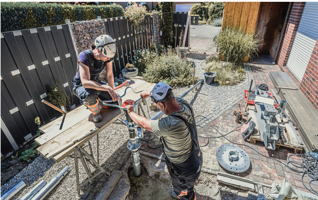
Abb. 3: Einbau eines Schraubfundaments. Fotograf Photomedia.
