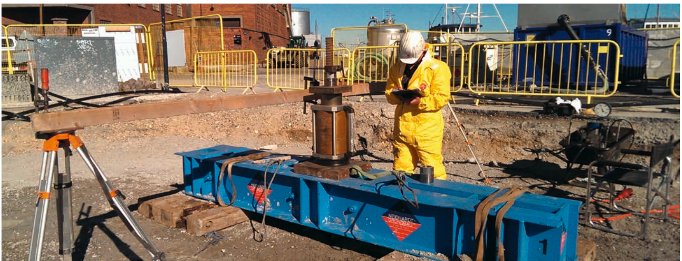
Bild 1: Eignungsprüfung eines Probepfahls an Baugrube 1/Auslassbauwerk am Hafen
