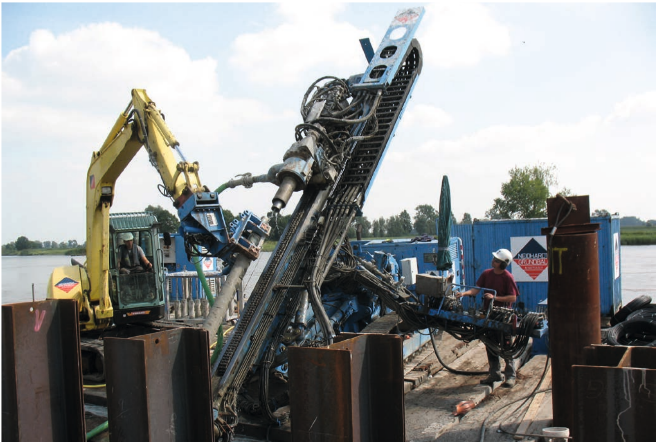
Bild 3: Wechsel des Bohrrohres
