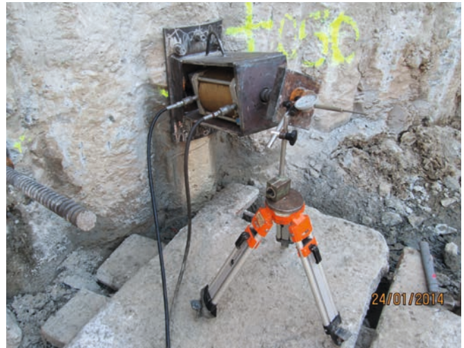
Bild 2: Druckprüfung am Gewi-Pfahl mit Spannsattel
