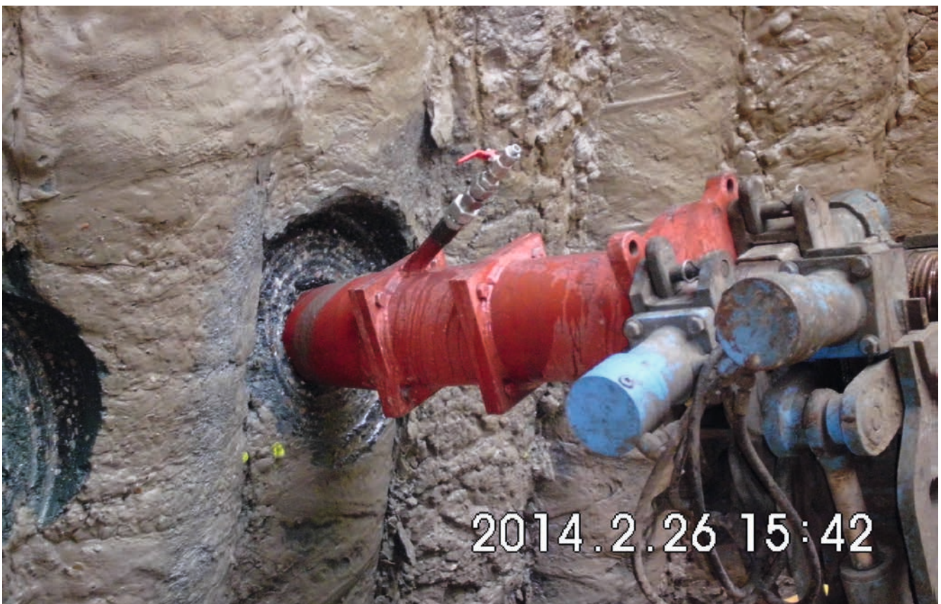
Bild 3: Bohren gegen drückendes Grundwasser mit Bohrpacker
