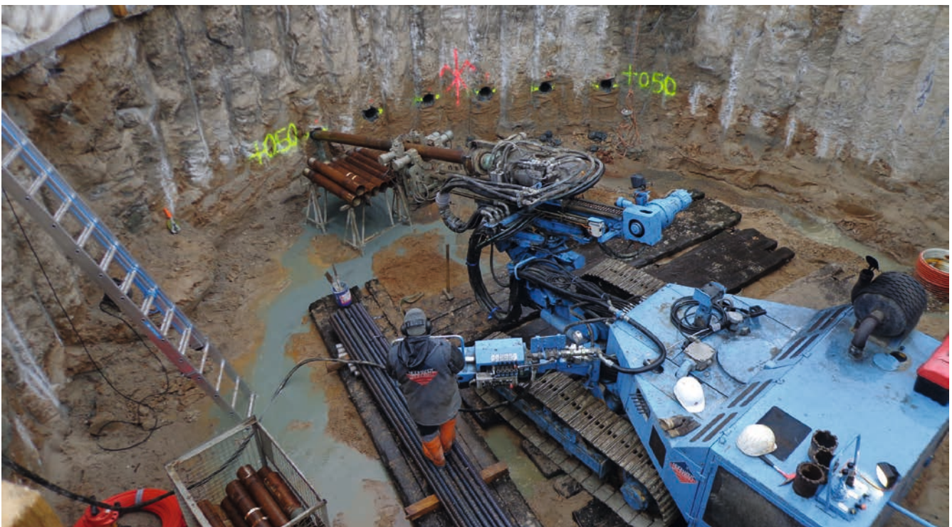
Bild 1: Bohrarbeiten in der oberen Ankerlage
