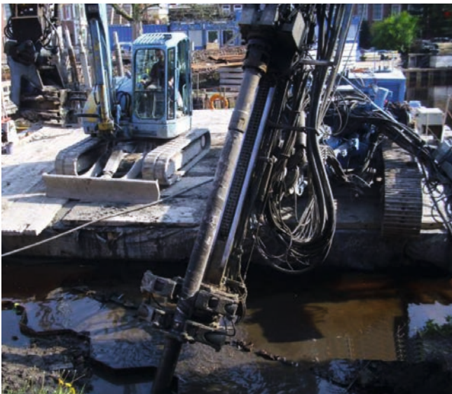
Bild 1: Bohrarbeiten vom Ponton
