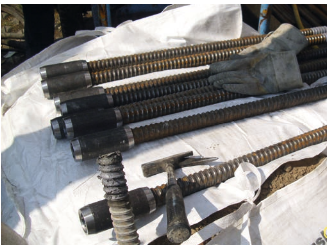
Bild 1: Tragglieder mit aufgeschraubter Muffe
