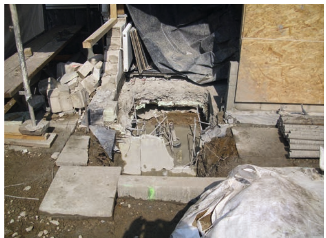
Bild 2: Pfahlbock im Erdgeschoss
