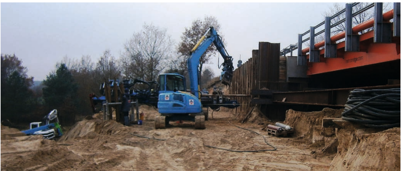
Bild 1: Herstellung der Horizontalanker auf der obersten Bohrebene
