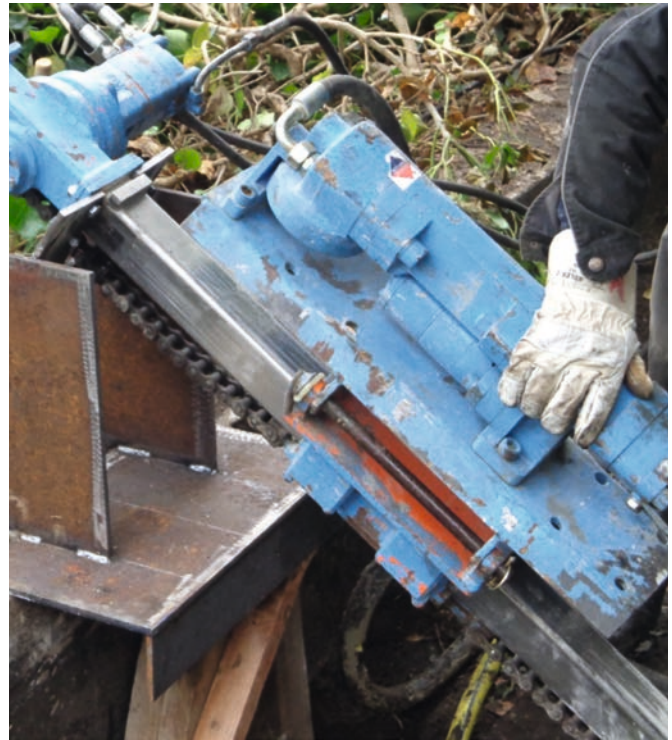
Bild 3: Ausbildung einer Stützeinrichtung zur Realisierung des Pfahlsneigungswinkels
