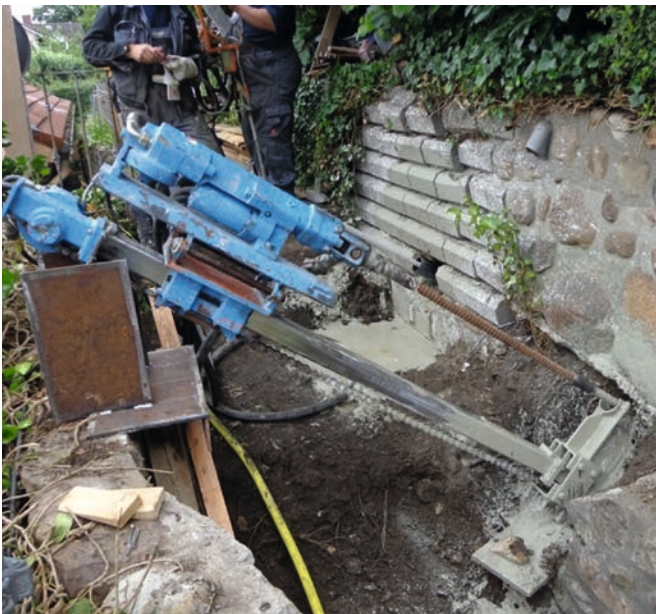
Bild 1: Herstellung eines Verpresspfahls mittels Handlafette
