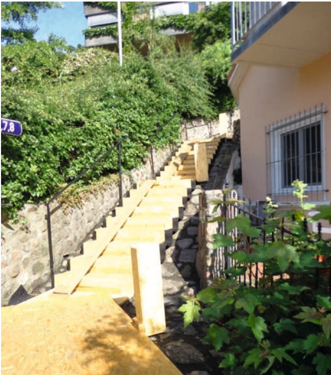
Bild 2: Eingeschränkte Zugänglichkeit mit Maßnahmen zum Schutz der bestehenden Treppenanlage
