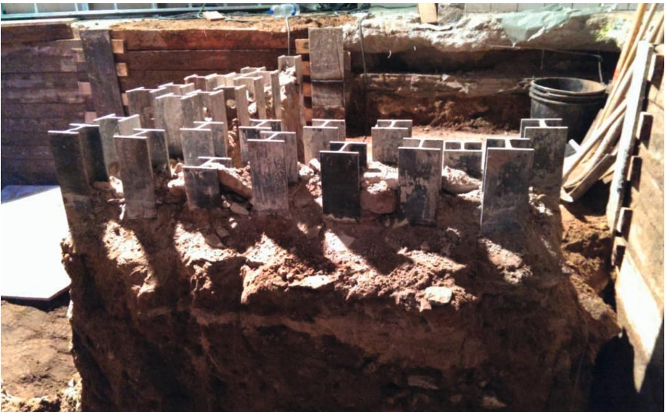
Bild 3: Ausbildung der Bohrpfahlwand mit Trägern HEB 100
