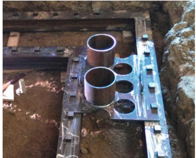
Bild 2: Schablone für Bohrpfahlwand
