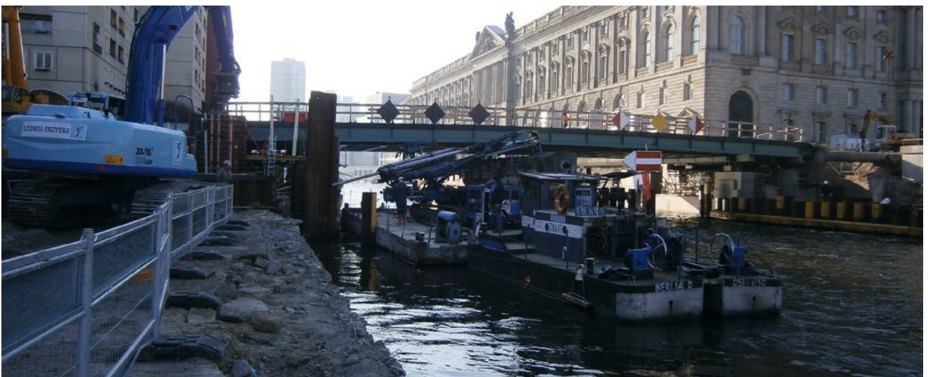
Bild 3: Bohrarbeiten wasserseitig
