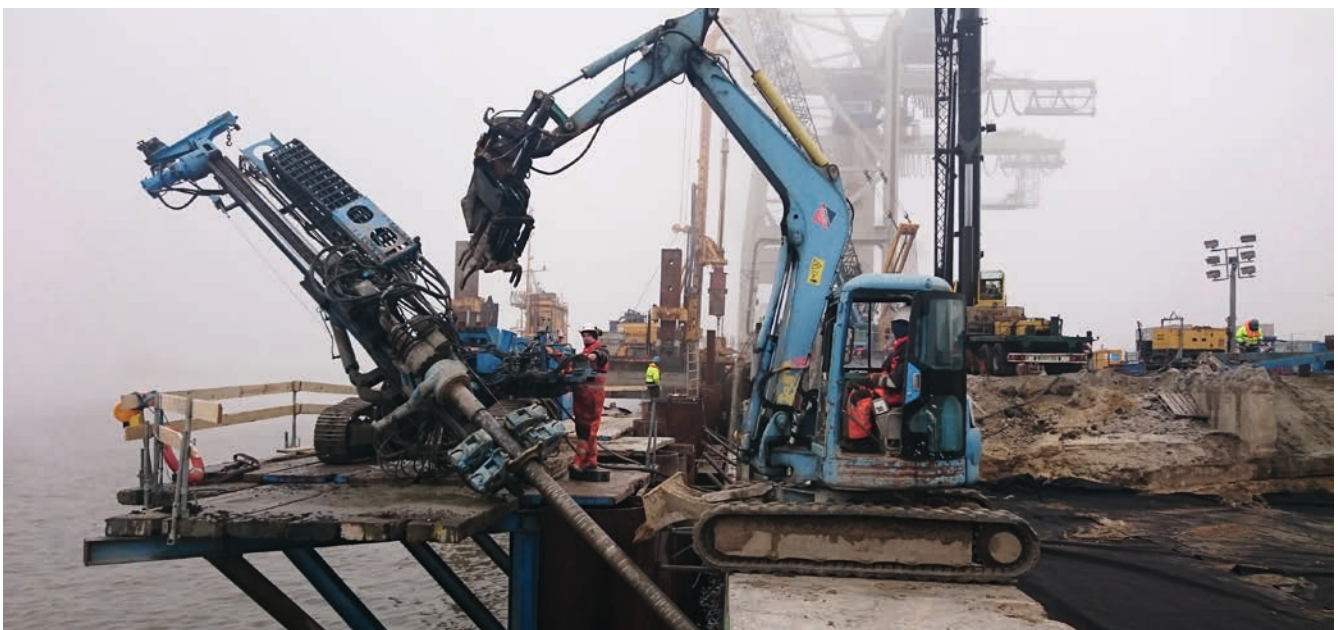
Bild 1: Hängegerüst mit Bohrgerät vom Typ Klemm 807
