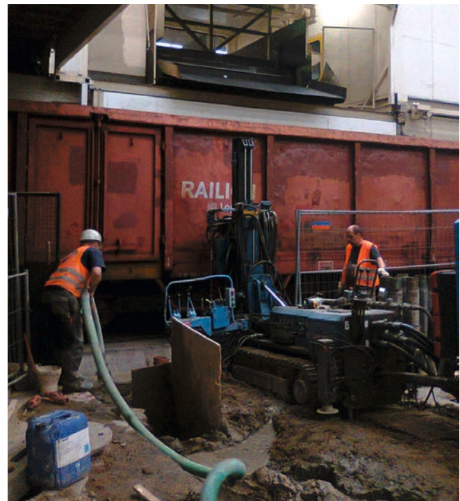
Bild 1: Beengte Verhältnisse unter laufendem Betrieb mit unserem Bohrgerät Klemm KR 702-2
