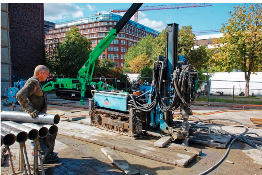
Bild 1: Bohrlochherstellung mit unserem kompakten Bohrergerät des Typs Klemm KR 702-2
